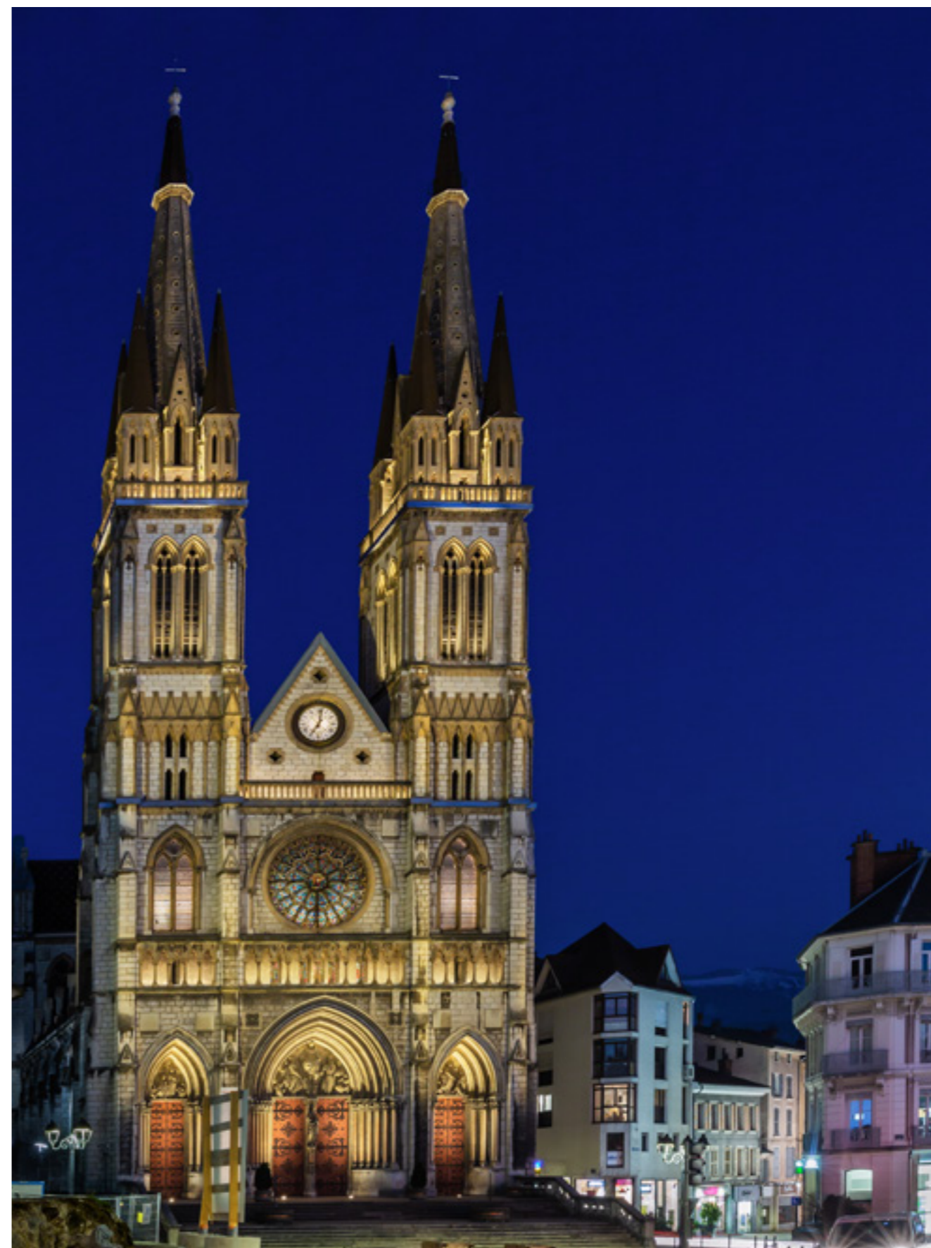
Église Saint-Bruno de Voiron Voiron (FR) Maître d'ouvrage : Ville de Voiron Maître d'œuvre : INGELUX Installateur : ECLAIRAGE SERVICE
