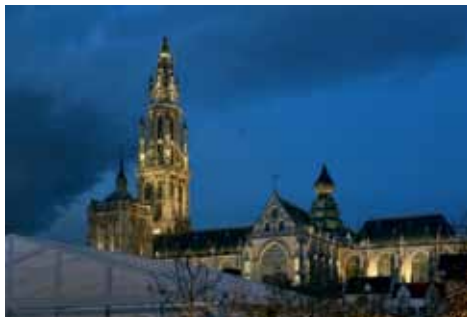
01 Depuis l'automne 2018, un nouvel éclairage met en scène ce chef-d'œuvre flamand de style gothique brabançon flamboyant. Photo : Serge Brison pour WE-EF
