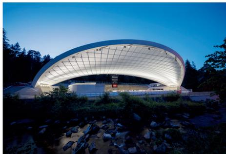
02 Die 2.400 Quadratmeter große Überdachung besteht aus einem Druckring in Stahlbaukonstruktion, einem dazwischen gespannten Stahlseilnetz sowie einer Bespannung mit PTFE-beschichteter Glasfaser-Membran.
