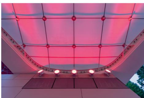
05 Je fünf an den Stirnseiten installierte FLC260-CC LED Scheinwerfer mit RGBW Farbwechsler lassen die Dachunterseite in jeder gewünschten Farbe erstrahlen.
