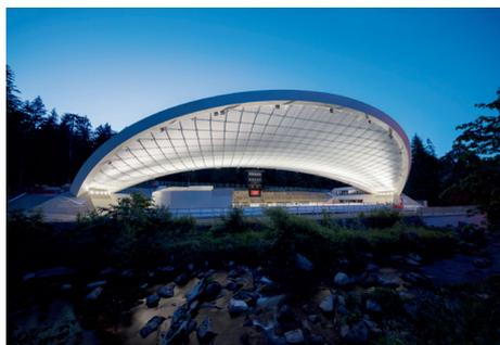
02 L'incroyable toiture incurvée de 2 400 mètres carrés se compose d'une ossature métallique arquée dans laquelle des câbles d'acier sont tendus et recouverts d'une membrane en fibre de verre revêtue de PTFE.
