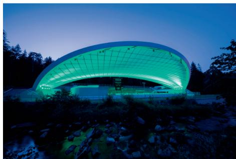
03 La structure ne repose que sur deux points du bâtiment, ce qui donne l'impression qu'elle flotte au-dessus de l'Arena.
