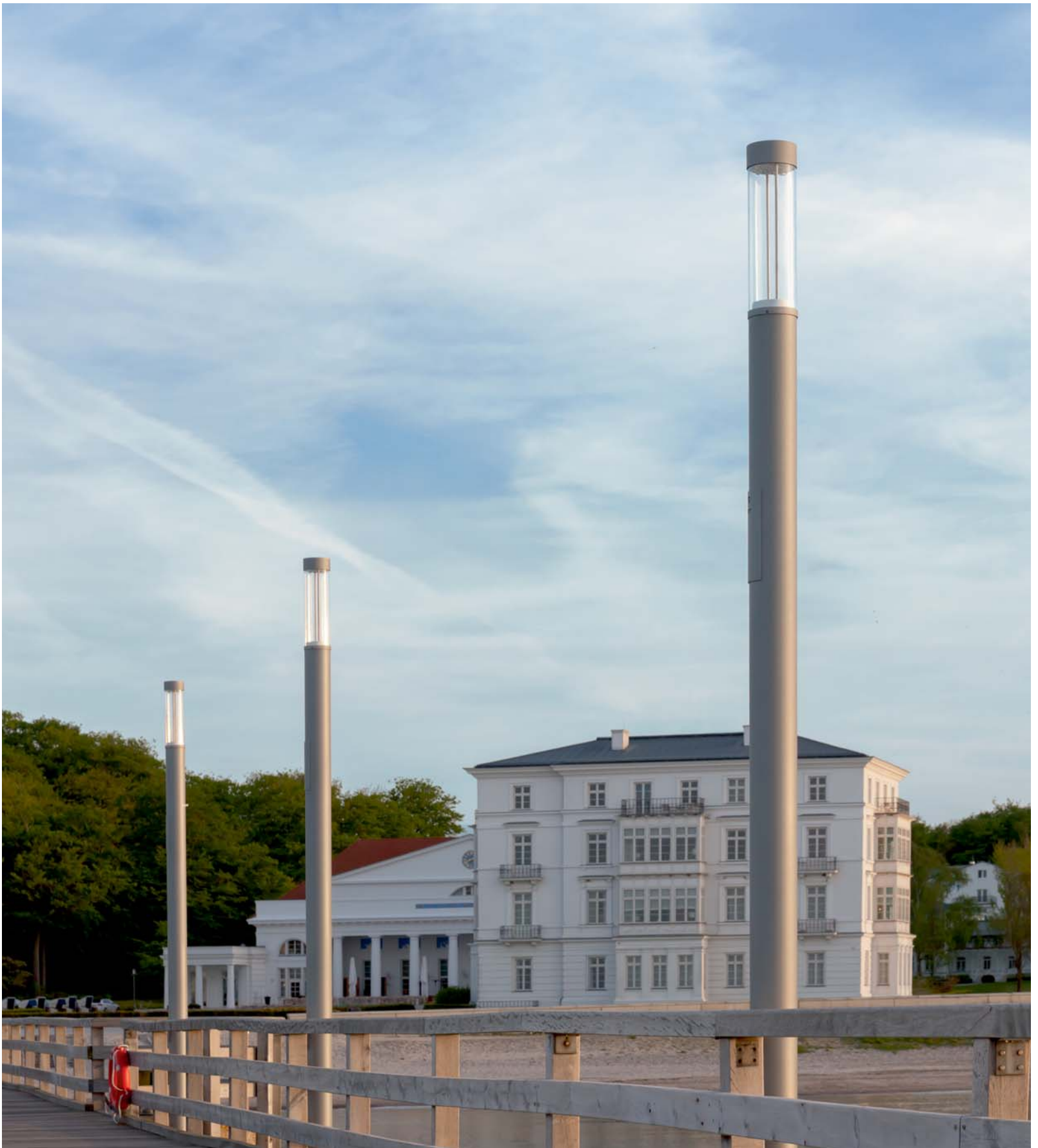
Pier seaside Heiligendamm (D). Lighting design: Institut für Gebäude + Energie + Licht Planung, Prof. Dr.-Ing. Thomas Römhild, Wismar.
