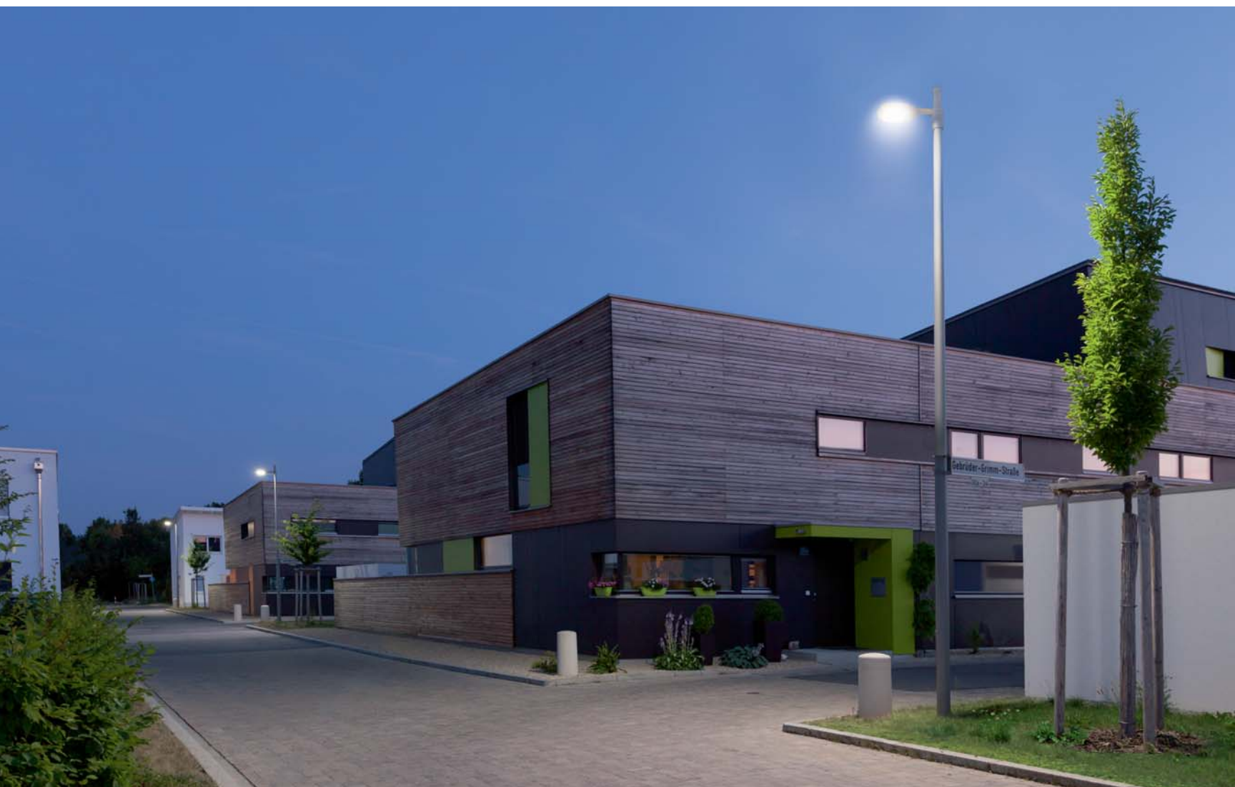
Residential area Zauberwinkel. Poing (D). Planning: Südhausbau München.
