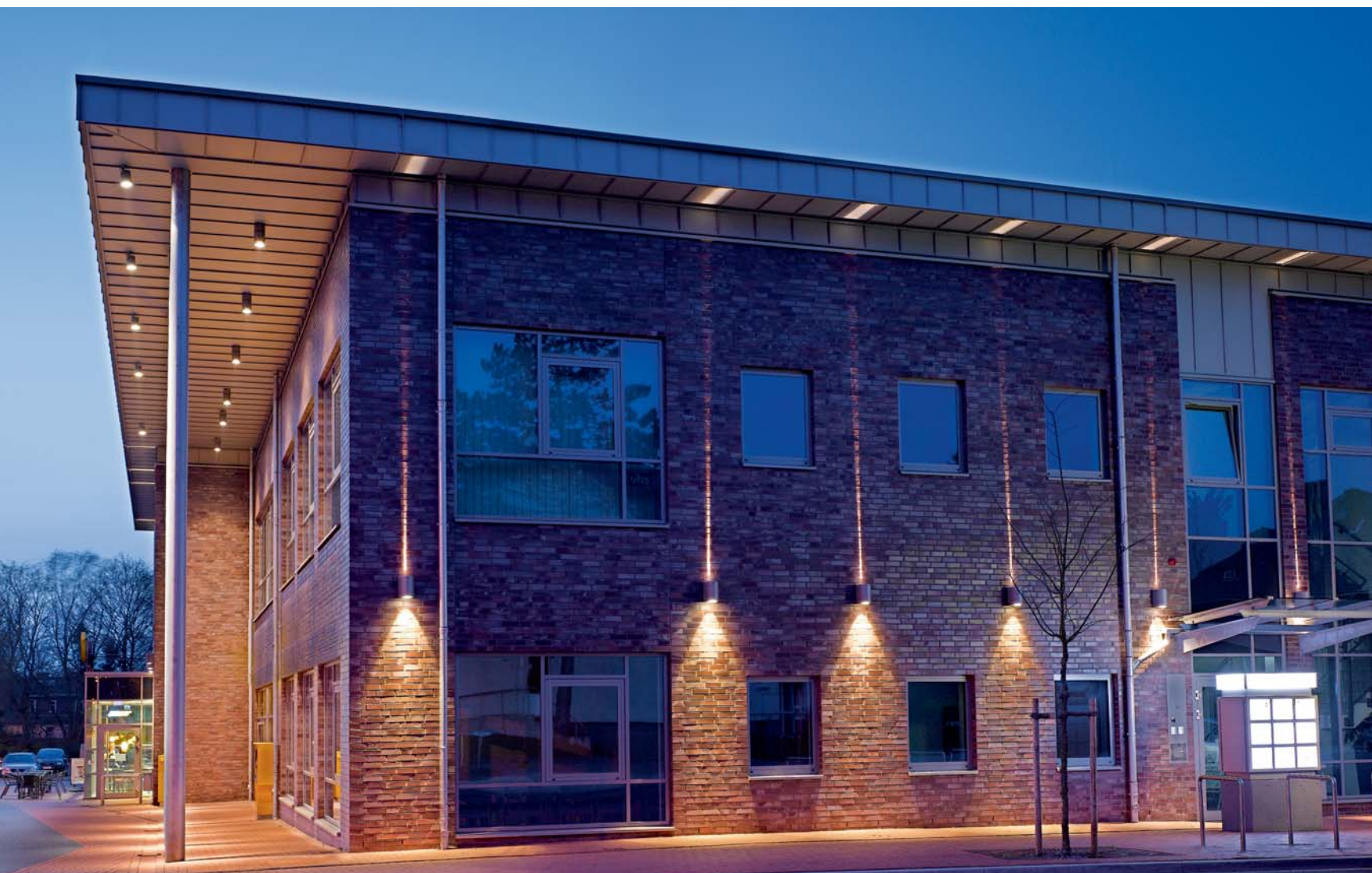
Town hall. Munster (D). Architect: Renken + Szygula.
