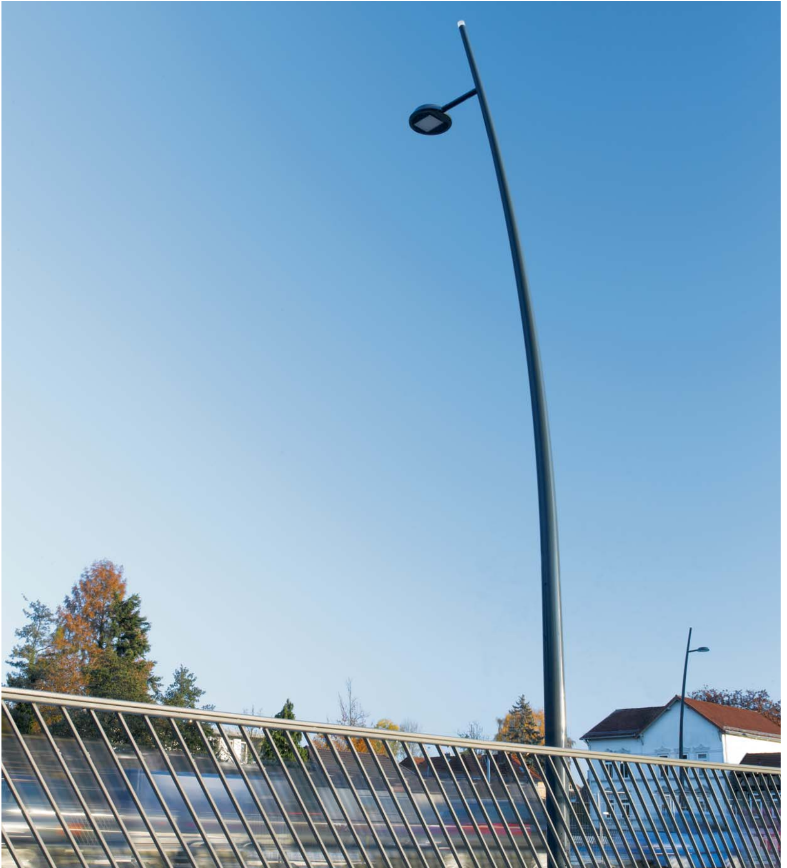
Aller bridge. Celle (D). Lighting design: SSP - Schmitz Schiminski Partner, Hildesheim.
