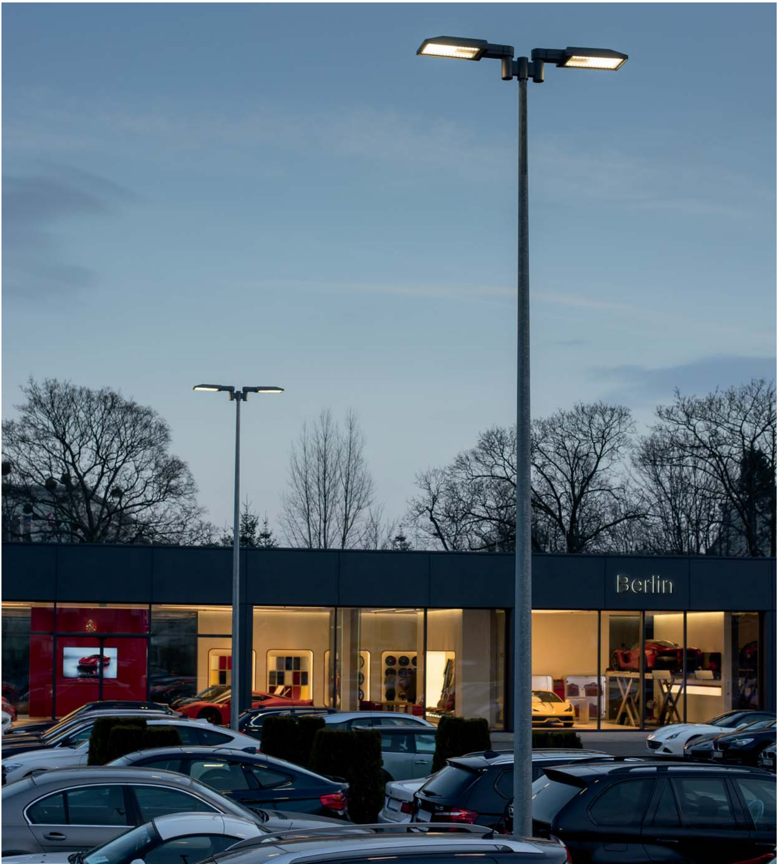
BMW car dealer Riller & Schnauck am Hindenburgdamm, Berlin (D). Planning: Uwe Nüßer, Gebäudemanagement Riller & Schnauck.
